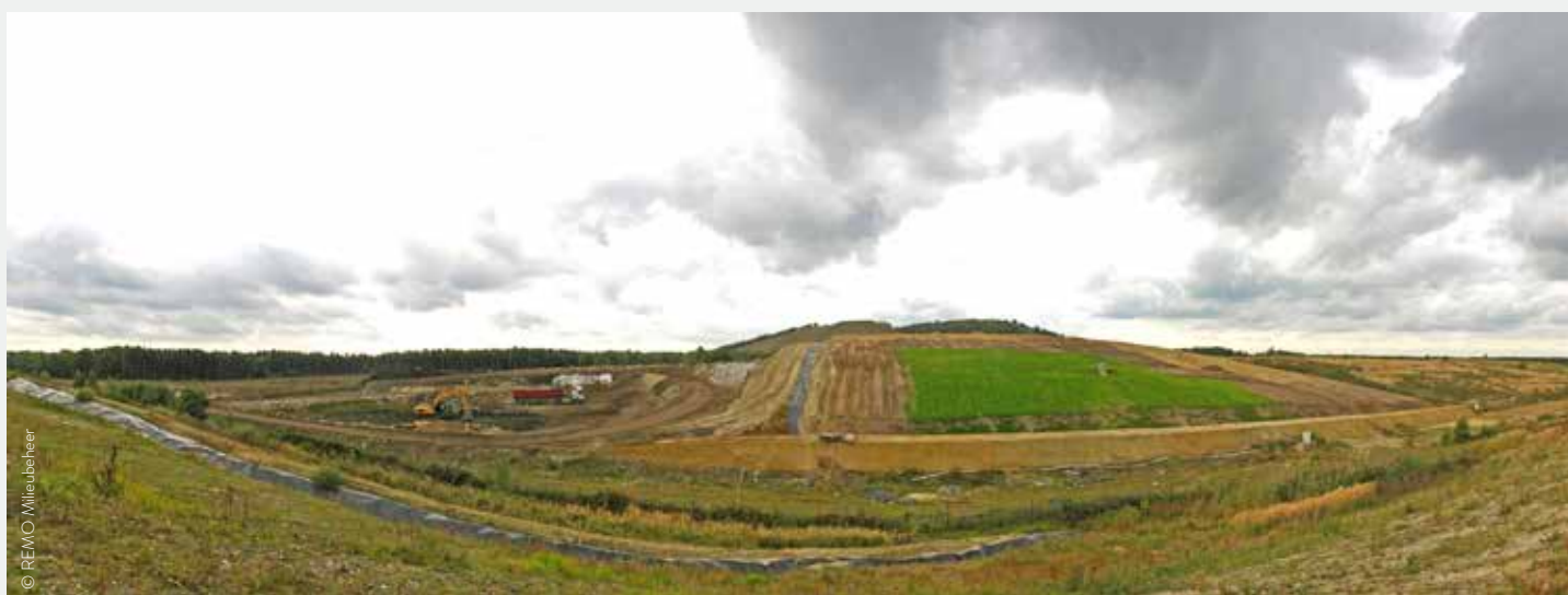
De REMO-site in Houthalen-Helchteren is de grootste en meest performante site voor opslag van industrieel afval in België.
